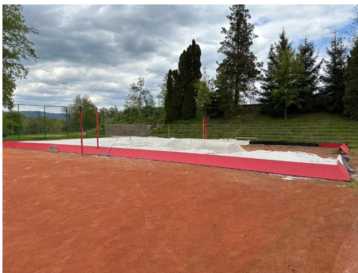
Budování třetího beachvolejbalového kurtu – duben 2024
