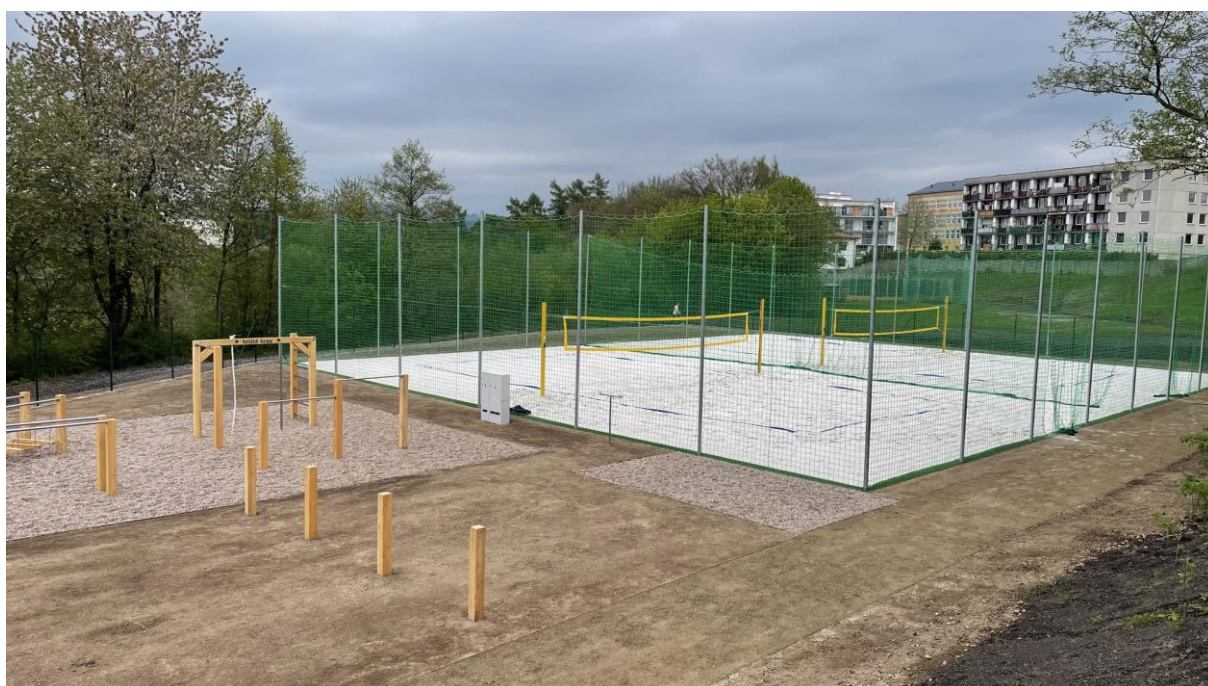
Dokončený areál beachvolejbalového areálu a volnočasové zóny – začátek května 2023
