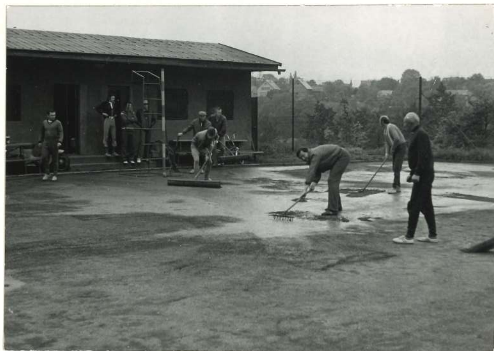
Úprava hřiště po dešti před utkáním „Čestla“.
